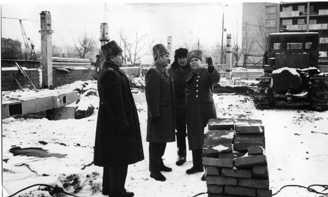
А.Н. Смуров на строительстве нового учебного корпуса.
